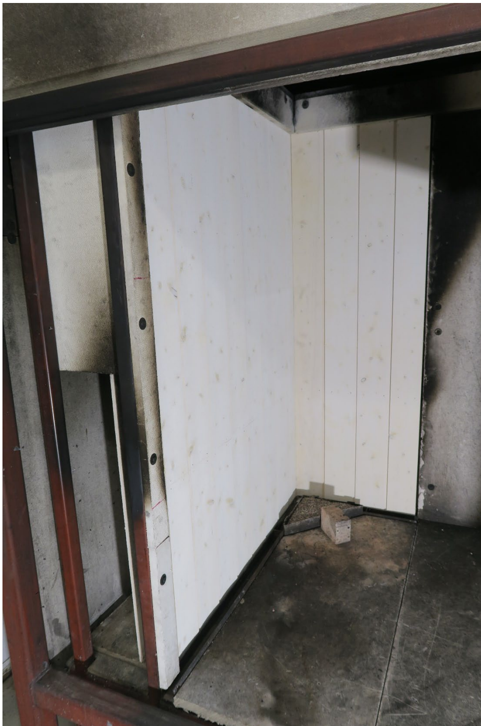
Foto nr 2 Före provning "C"
