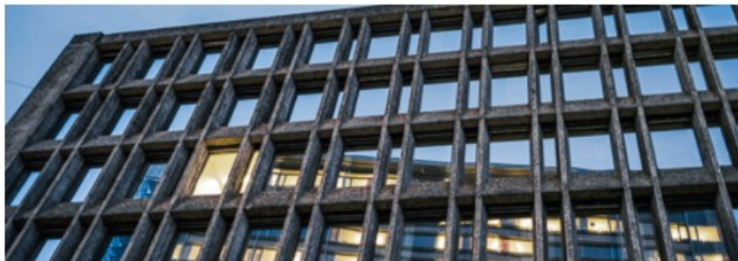
Forslag som er på høring gjelder endring i energiforsyningskravet til bygninger over 1000 m 2 Foto: Ilja C. Hendel
