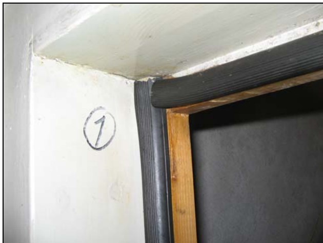
Figur 23: Gummilist som tetteliste rundt dør til kjølerom
