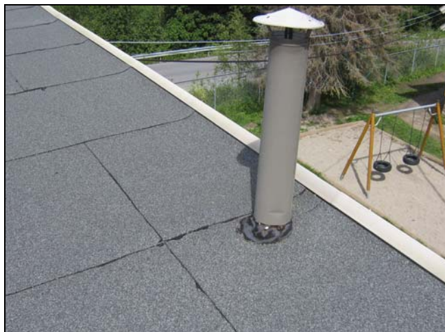
Figur 17: Asfaltpapp takbelegg
