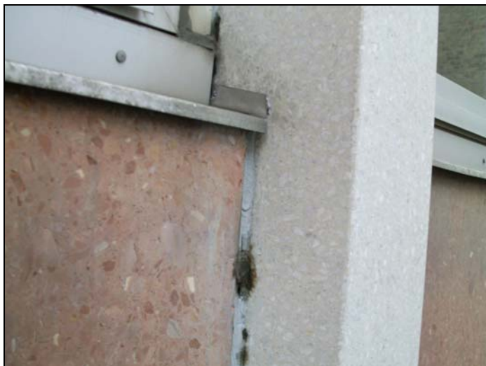
Figur 18: Lys grå fugemasse mellom betongelementer
