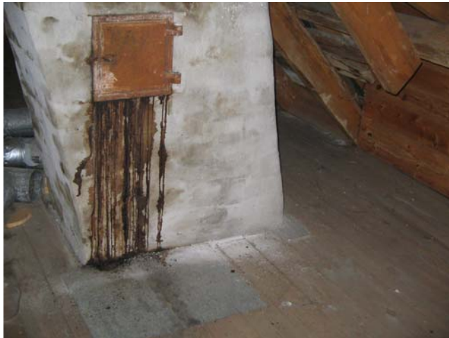
Figur 29: Murpuss på pipe på loft
