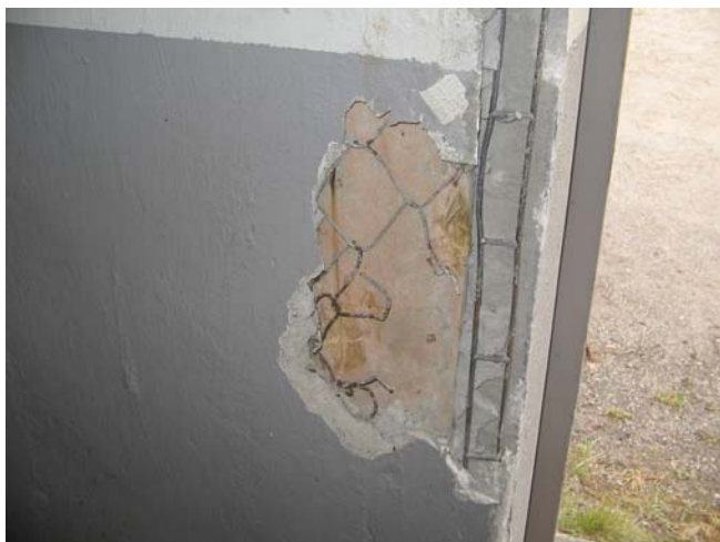
Figur 30: Murguss med maling på
