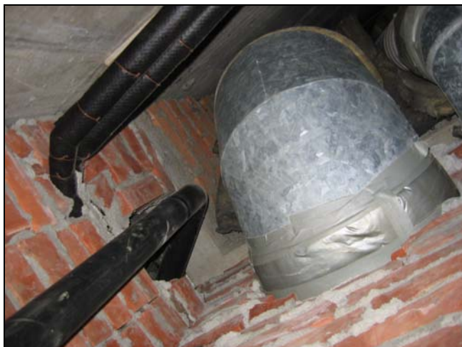
Figur 34: Teglstein, her som vegger i teknisk sjakt
