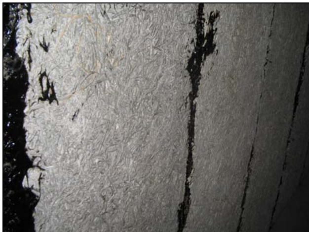
Figur 19: Lim (mellom treullsementplater)
