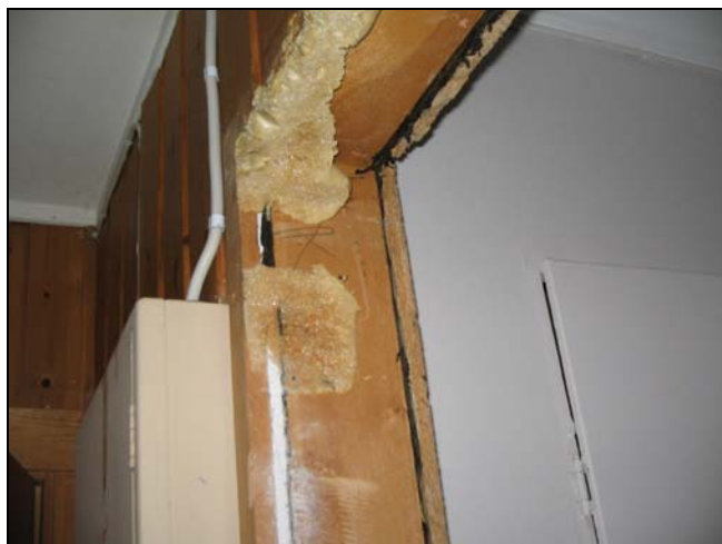
Figur 8: Fugeskum rundt dør
