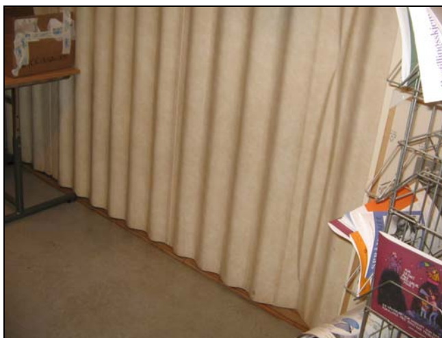
Figur 26: Foldevegg av PVC med DEHP-innhold på 21000 mg/kg
