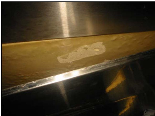
Figur 4 Polyuretanplate i tak i kjølerom
