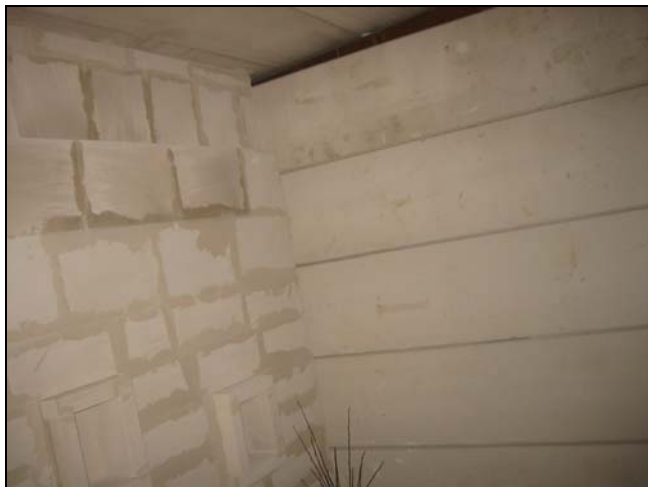
Figur 33: Siporexblokker har hvit farge
