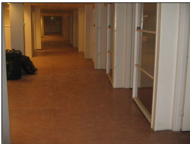
Figur 11: Linoleumsbelegg på gulv i kontorlokale
