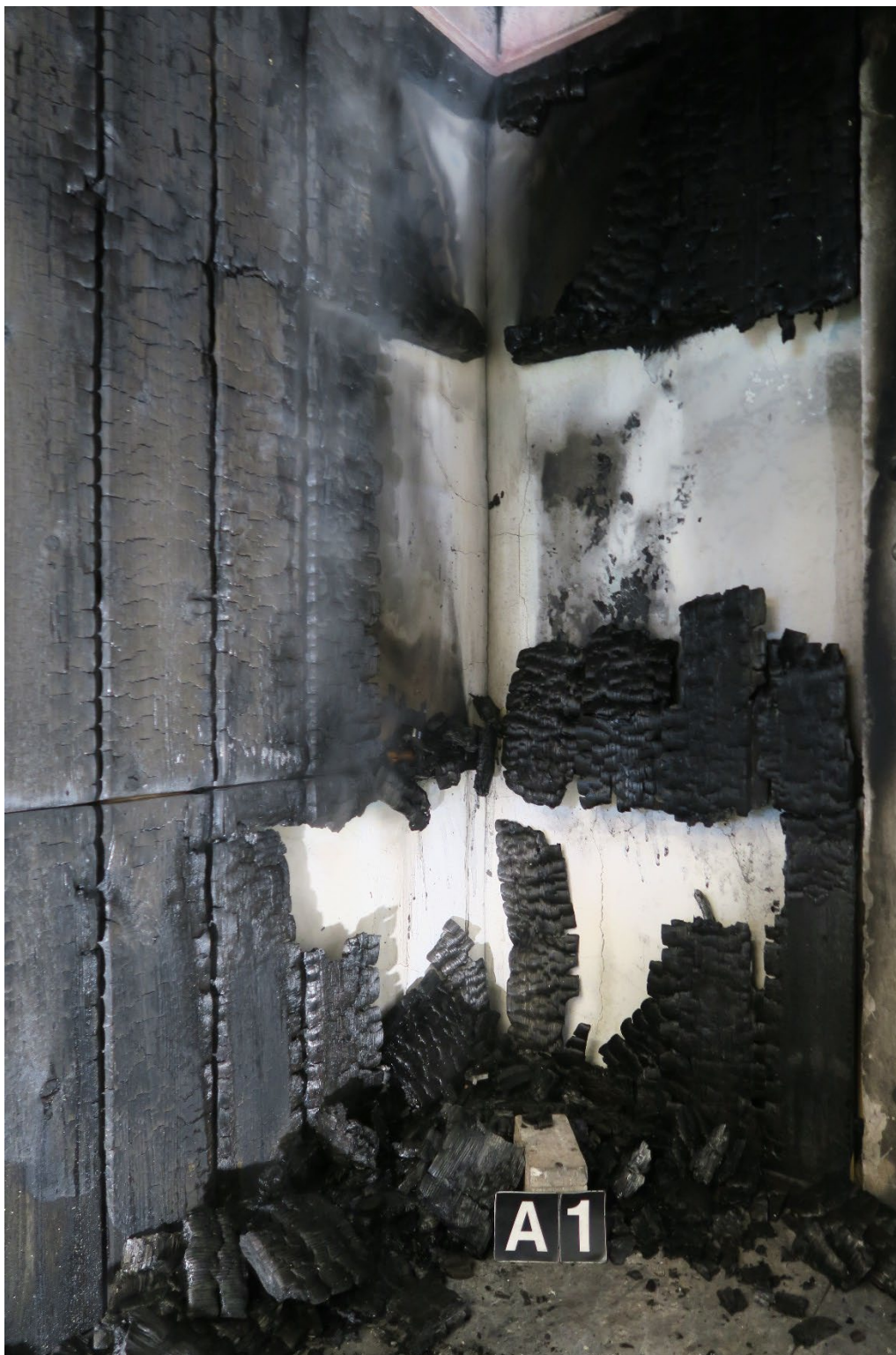
Foto nr 3 Efter provning "N"
